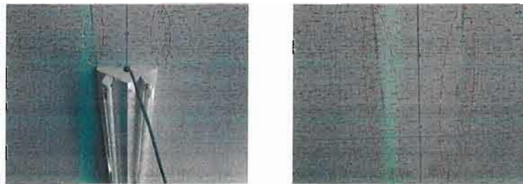
従来器具を取り外すと天井には器具跡が残っている。リニューアル時の大きな問題点
