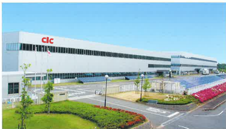
長州産業(株)本社工場 太陽光発電 100kWシステム
